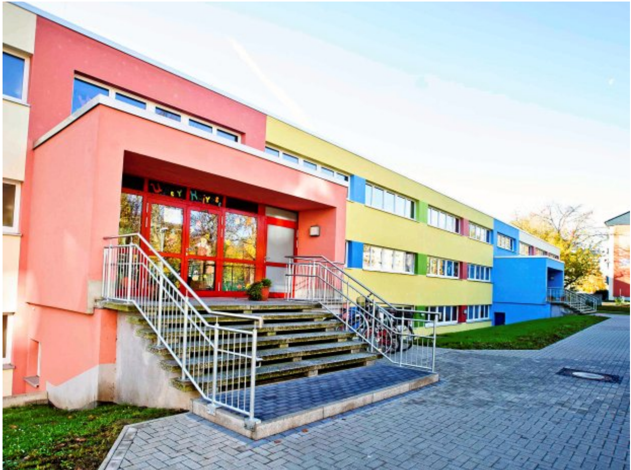
Der Kindergarten Am neuen Ufer ist der größte in Mühlhausen. Das Gebäude stammt aus dem Jahr 1979 und wurde vor wenigen Jahren umfangreich saniert. Foto: Daniel Volkmann
